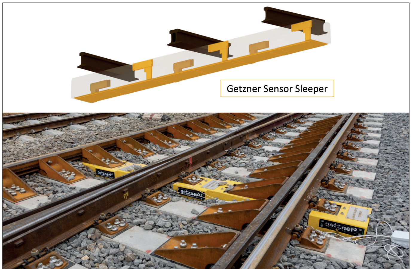
Bild 14: Einbauzustand und Messung im Shift2Rail Projekt
